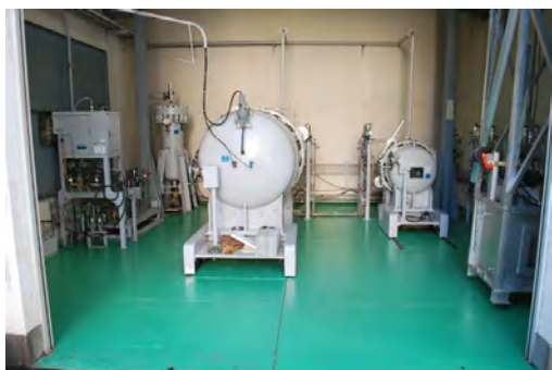
5. 防爆試験装置 (防爆試験槽)
