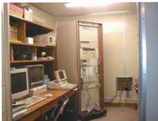
1. 電波暗室（計測室）
