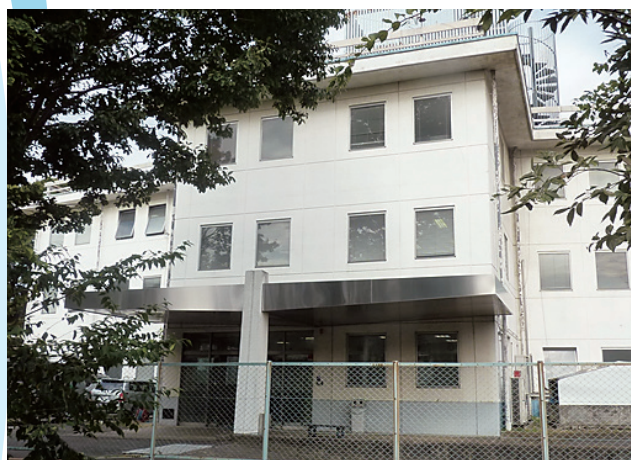
製品安全評価センター(RIME)本館
