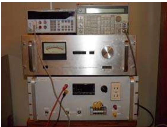
伝導低周波妨害試験装置
