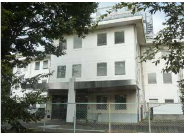
製品安全評価センター本館
