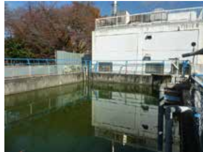
落下試験水槽 (屋外) 内法寸法 W15m D10m 水深 3.5m 射水装置 (膨脹式救命いかだの落下試験/射水試験)
