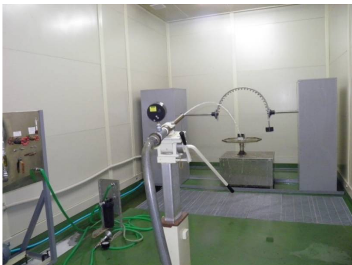
新設された防水試験室
